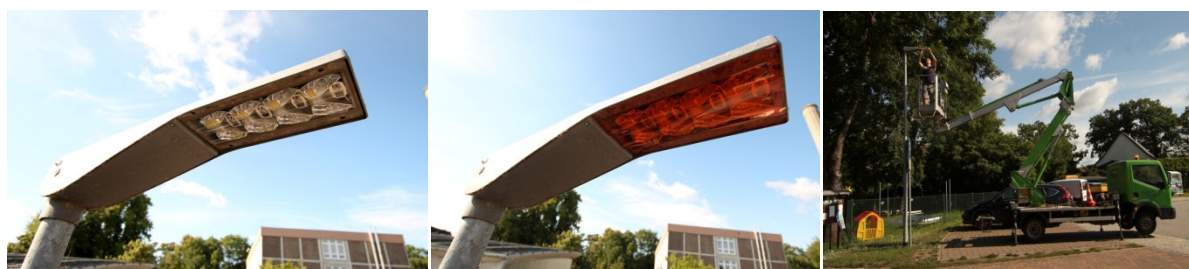
Abb. 2-4: Leuchte ohne (links) und mit Folie. Umrüstaktion mit Hebebühne (rechts).
